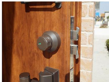
ボールなどによるこじ開けを防ぐためにデッドボルトの先端より鎌部品が飛び出す鎌デッド錠を採用しました。
